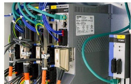
Die Kombination aus dem PCMM Motion Controller und AKD Servoverstärkern bildet bei Breyer einen kompakten und leistungsstarken Motion-Control-Verbund.
