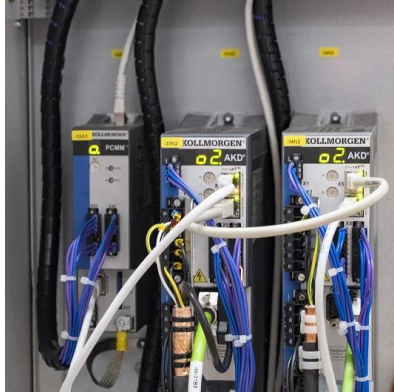
Solda KOLLMORGEN'in kompakt ve yüksek performanslı PCMM Kontrolörü ve AKD Servo güçlendiricisi. Sağ tarafta güçlü ivmelenmesiyle AKM Servo motor.
