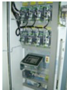
Photo 03 In totale vengono usati otto azionamenti AKD e un PC industriale di Kollmorgen.
