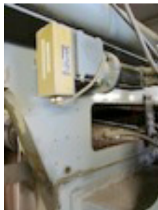
Foto 02 È stato possibile dapprima continuare ad utilizzare i vecchi motori con i servoamplificatori AKD, per poi passare gradualmente ai motori AKM.
